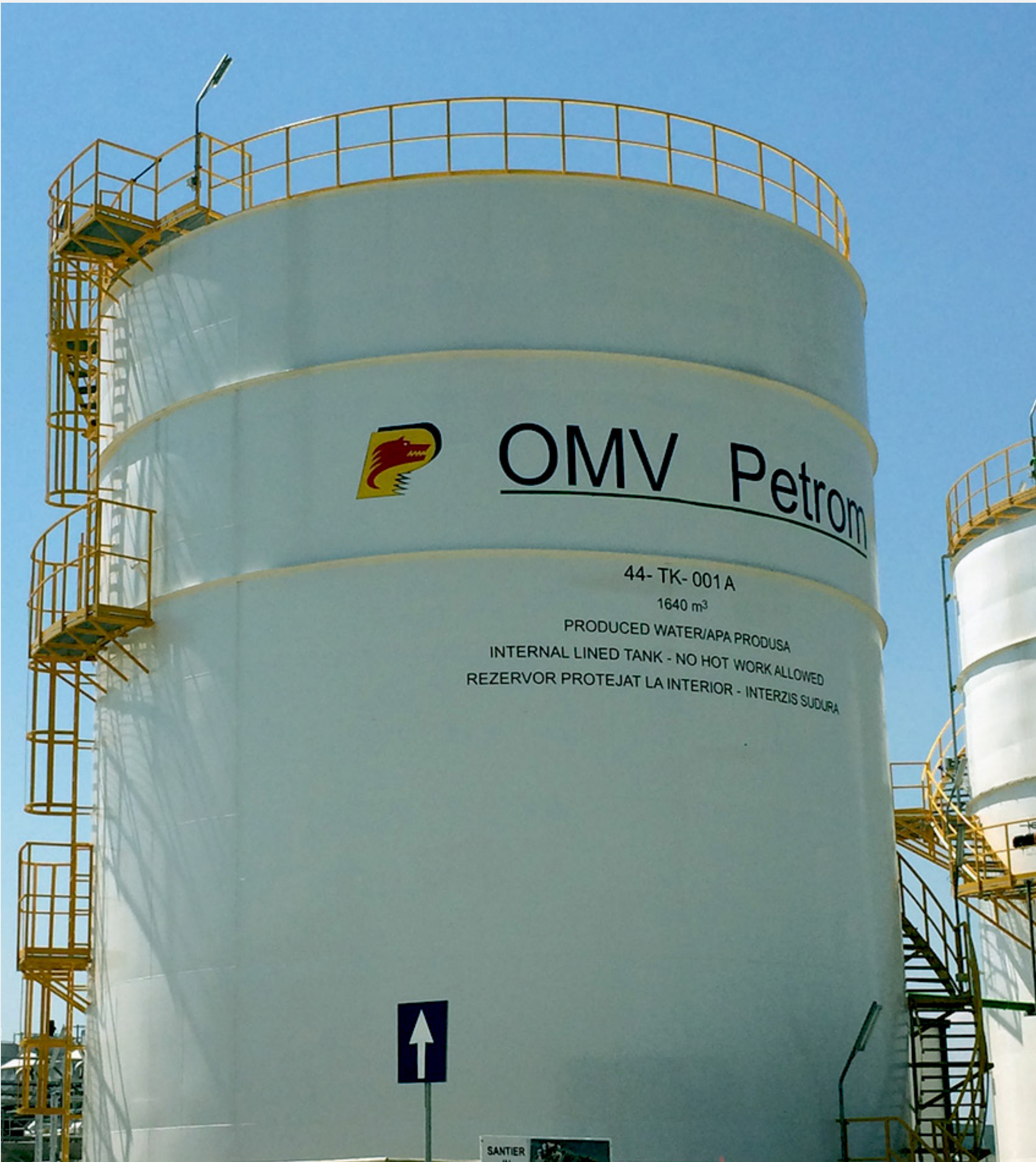
Statie de tratare a apei, Suplacu de Barcău
